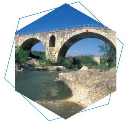
Pont Julien, Calavon-Coulon
