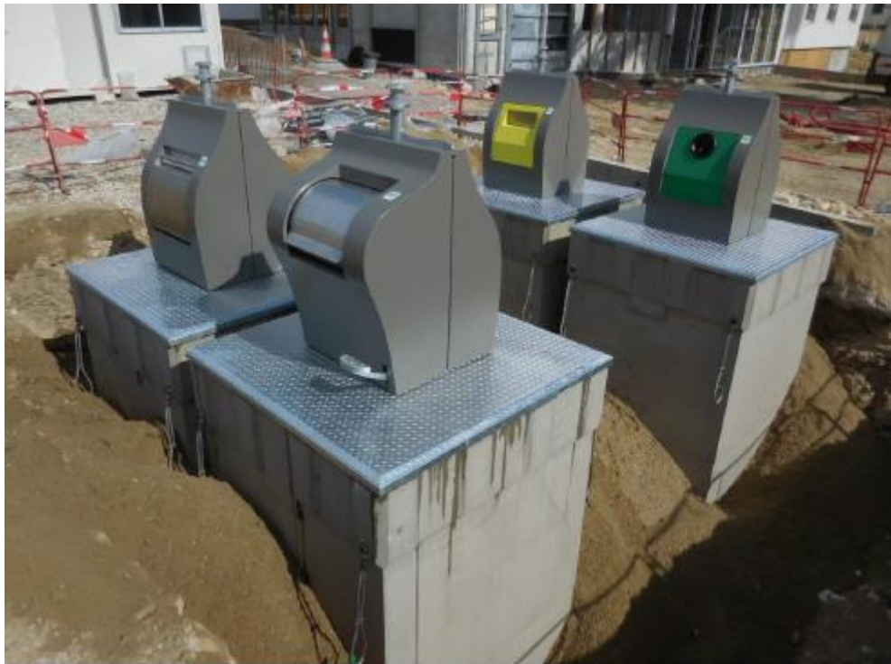
Figure 65 : Remblais des fouilles – Source : SULO
