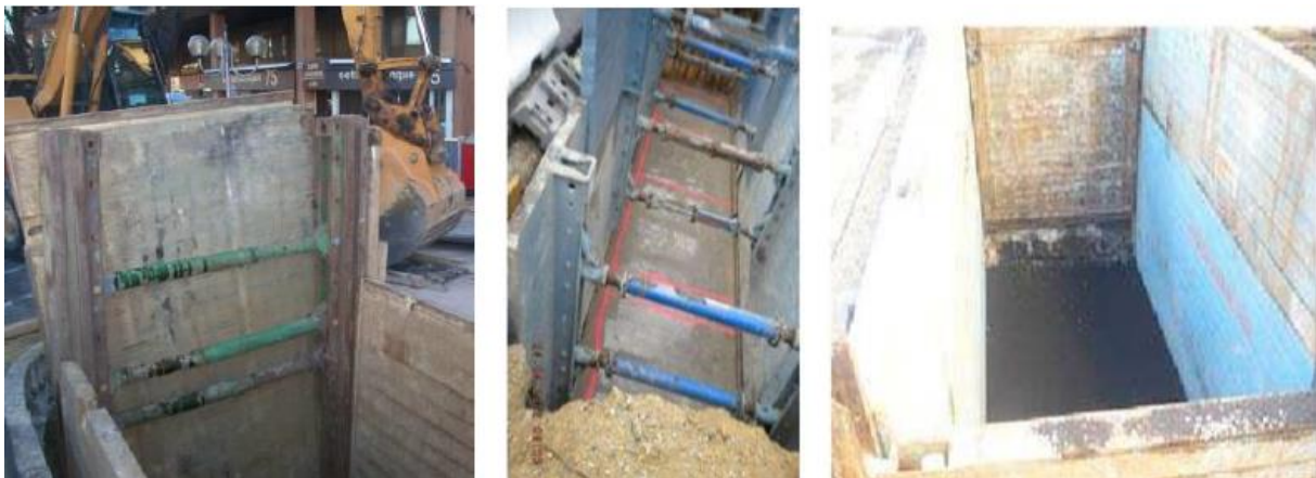
Figure 63 : Blindage des fouilles – Source : SULO
