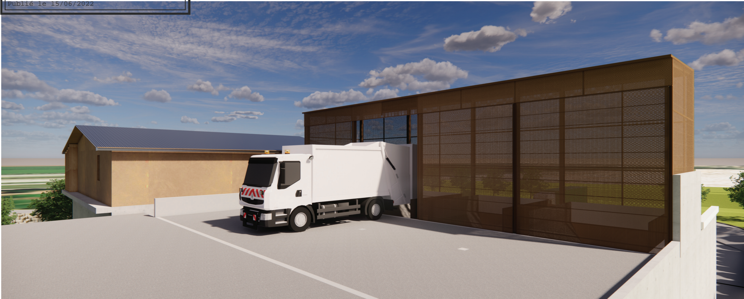
Vue depuis le Sud/Ouest
