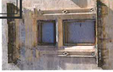
Baie à traverse Renaissance
