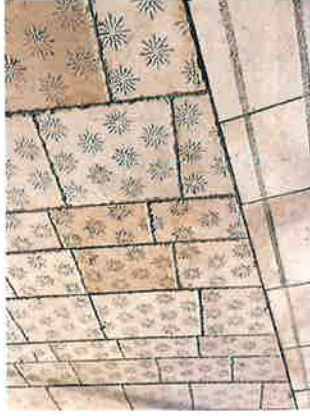
Cassis : traitement de sol
