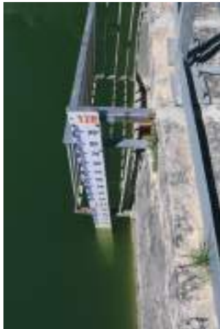
Installation d'une échelle hydrométrique
