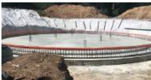
Construction du réservoir d'eau potable qui alimentera Maussane, Les Baux, Le Paradou.
