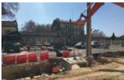
L'esplanade de la mairie, en travaux, à Saint-Etienne du Grès.
