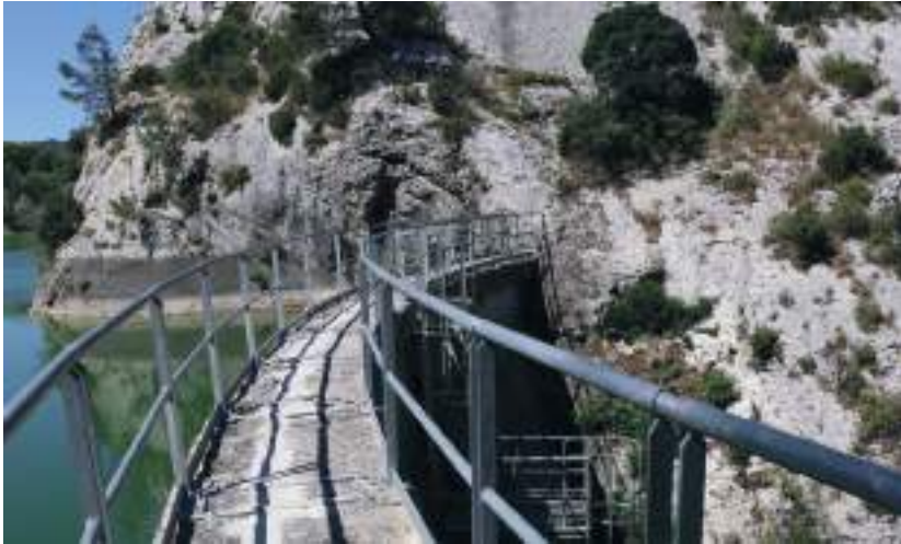
Remplacement des barrières de sécurité
