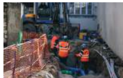
Travaux d'assainissement à l'espace Libération, à Saint-Rémy de Provence. Photo@communicationVilledesaint-remyde-provence
