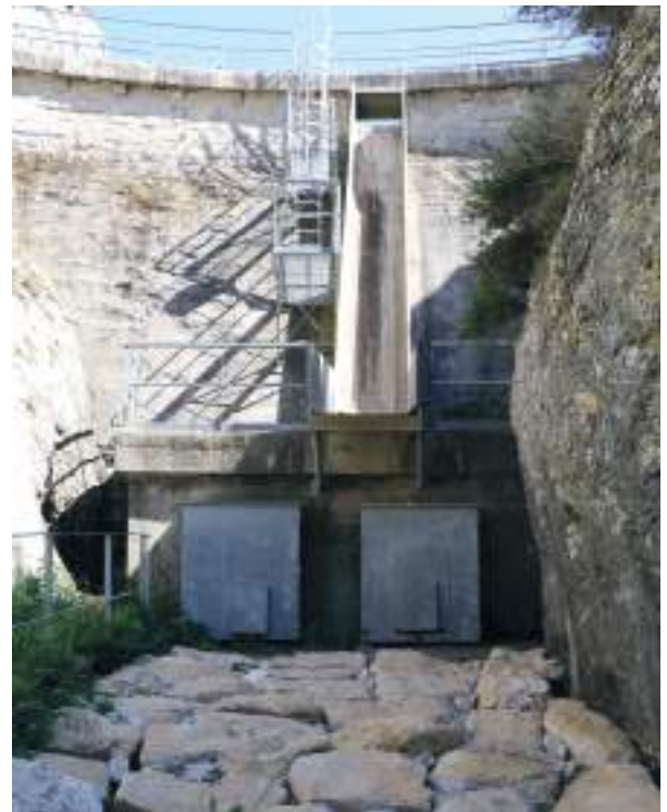
Installation d'un dissipateur d'énergie
