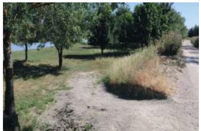
Création d'une rampe handicapée pour permettre aux personnes à mobilité réduite d'accéder aux bords du lac
