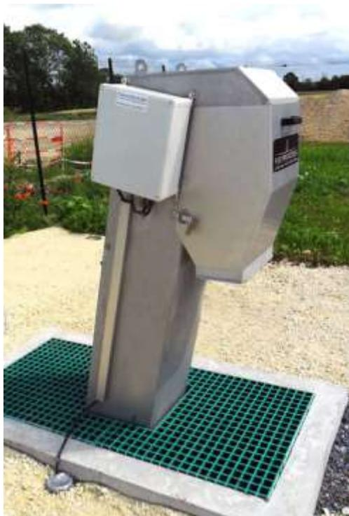
Compte tenu des débits projetés et de référence de l'installation actuelle, la lame aura la répartition suivante 13 / 87. Cette installation rustique permettra de répartir le débit de manière proportionnelle sur les 2 installations en cas de surcharge hydraulique.
