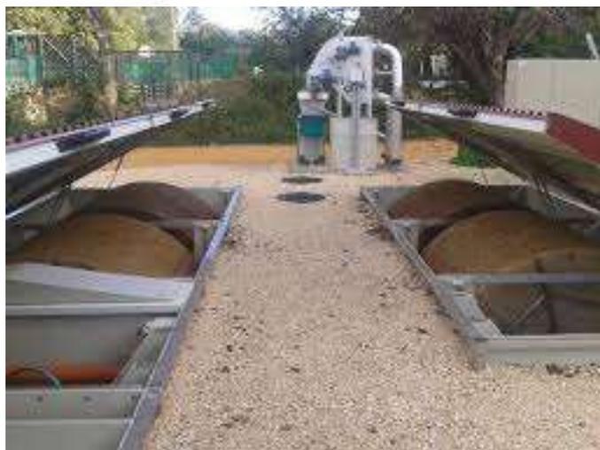
Cette filière nécessite la mise en place d'un tamis fin en tête et d'un dispositif de séparation des effluents traités et des boues produites.
